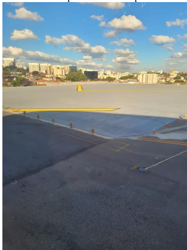
Figura 3 EMAS implantado no Aeroporto de Congonhas. Fonte: Autores, 2022.
